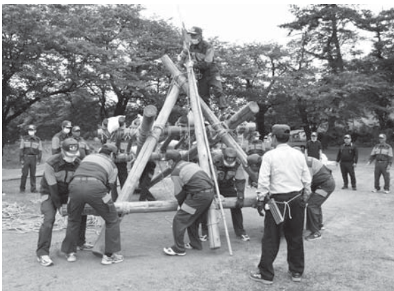
水防工法「川倉工」
